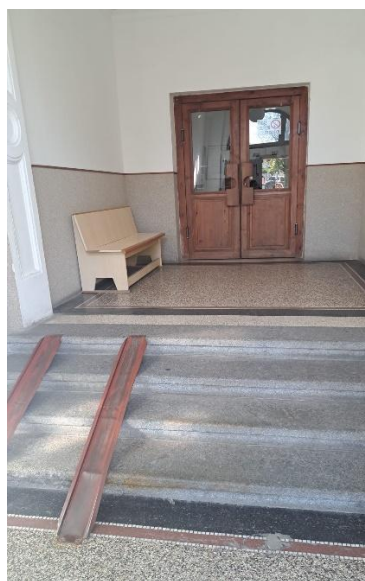
1 NP vstup do čekárny za hl. vchodem
