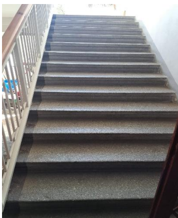
Schodiště do 2 NP
